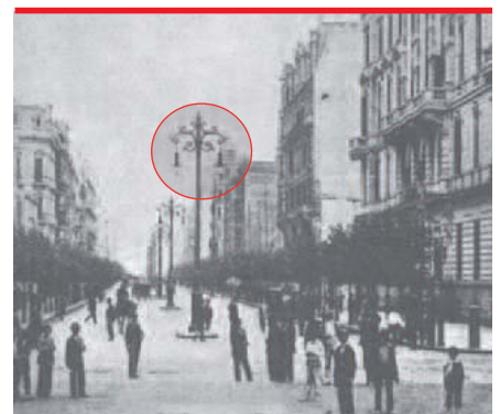
La Avenida de Mayo de Buenos Aires en 1896, con sus entonces novedosas luminarias incandescentes de 220 voltios.
